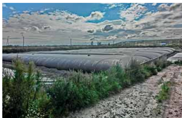
▲ Рис. 3. Общий вид площадки с геотубами
